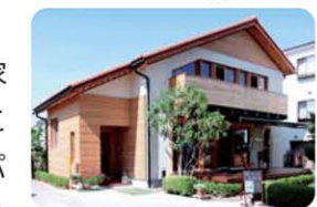
パッシブハウス改修(2013年)
