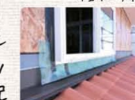
サッシ取付け
